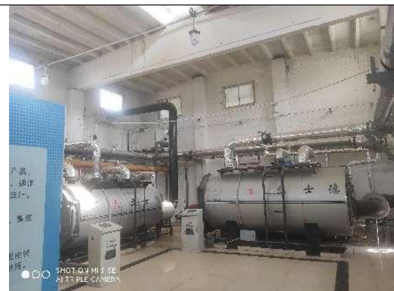
锅炉基础减震
