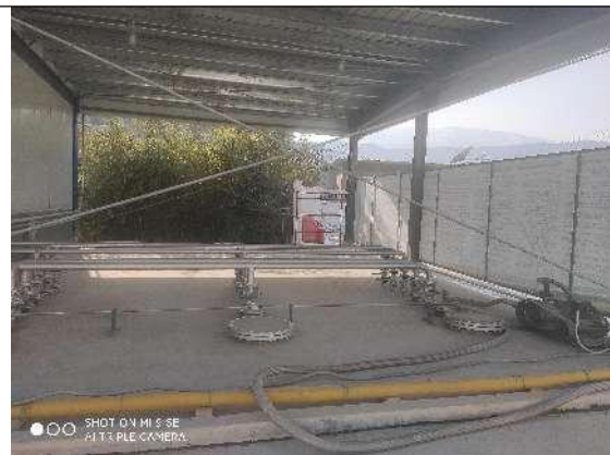
地理储罐防渗
